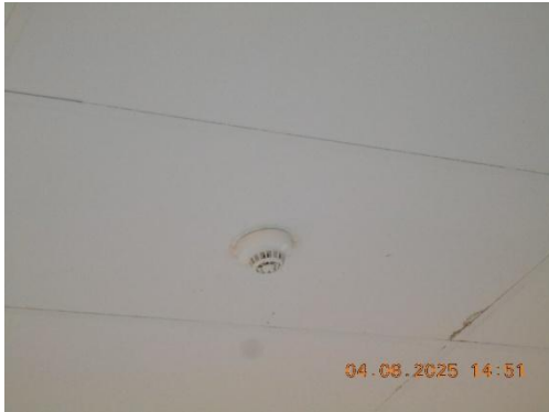
รูปที่ 29 Smoke Detector
