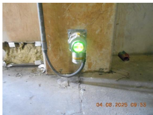
รูปที่ 27 Flammable Gas Detector
