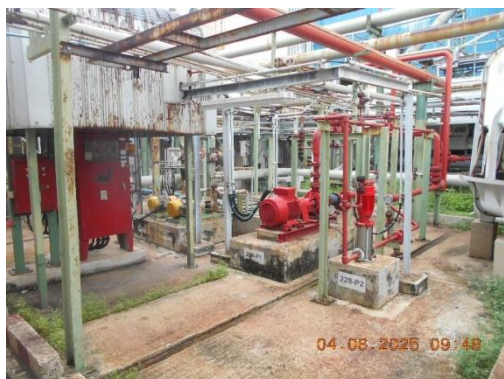
รูปที่ 25 ระบบท่อส่งน้ำดับเพลิง
