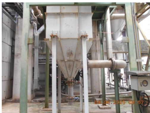
รูปที่ 3 Bag Filter ในระบบดําเนินการไนลอน
