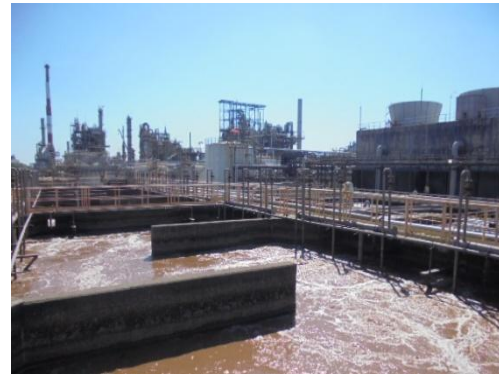
รูปที่ 8 ระบบบำบัดน้ำเสียของ โรงงานผลิตสารคาโปรแลกตาม์
